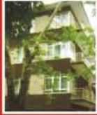
Çınar Apartmanı 37.Sok.Bahçelievler
